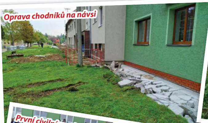
Oprava chodníků na návsi
